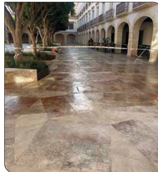
Obras de remodelación de la Plaza del Ayuntamiento. Almería. 2025.
