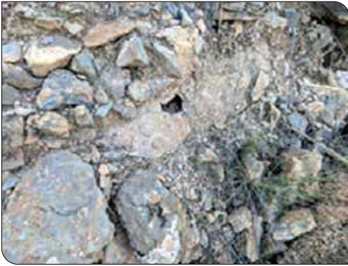
Estabilizando la canalilla con mortero.
