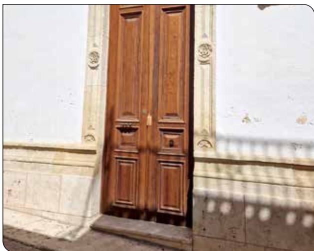
Detalle de la puerta de entrada a la casa de Los Canelos.
