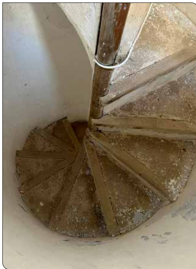
Interior del caracol en la casa de Porfirio.
