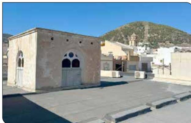
Vista del terrado en la casa de Porfirio Marín, cubierto ya con tela asfáltica.
