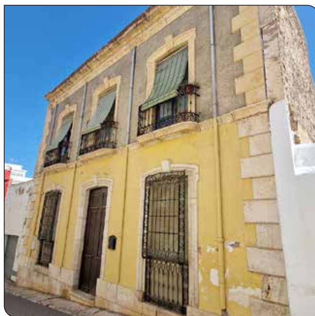
Casa de Cristóbal Rodríguez Lázaro: Vivienda burguesa de la época.
