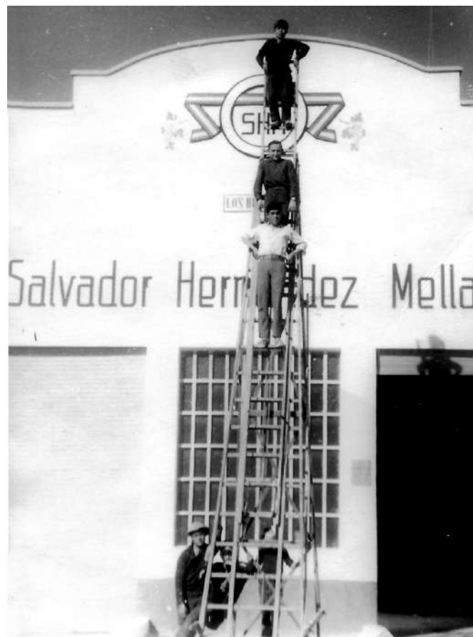
Fachada de los nuevos almacenes de Huéchar. 1965. En la escalera están varios jóvenes, entre ellos José Mesas. Colección Francisco Mesas Martínez.
