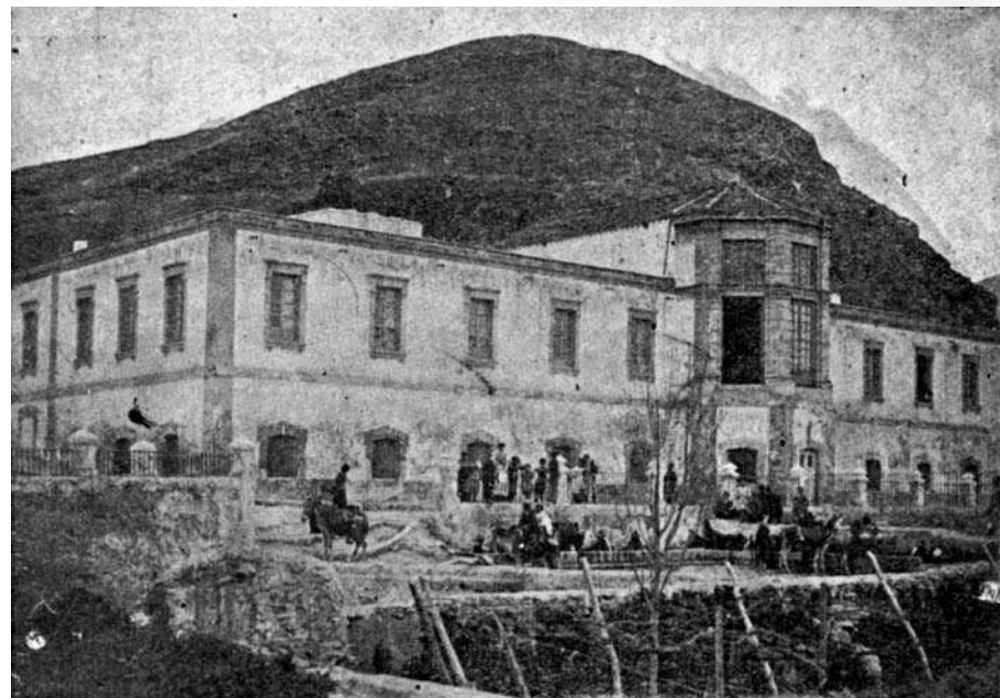
En el centro de la imagen se aprecia el tambor del establecimiento. Archivo Biblioteca Diputación de Almería.
